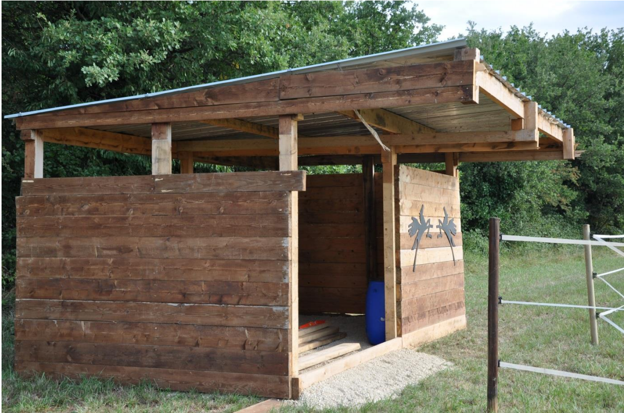
Bald ist der Unterstand fertig 11. 08. 2014
