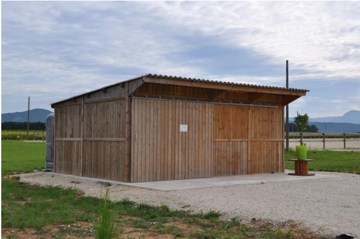
das Schmiedehäuschen mit Solarium und Heißwasser-Dusche
